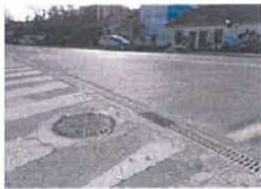
Detalle rejilla de hormigón
