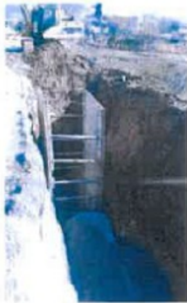
Detalle instalación del colector
